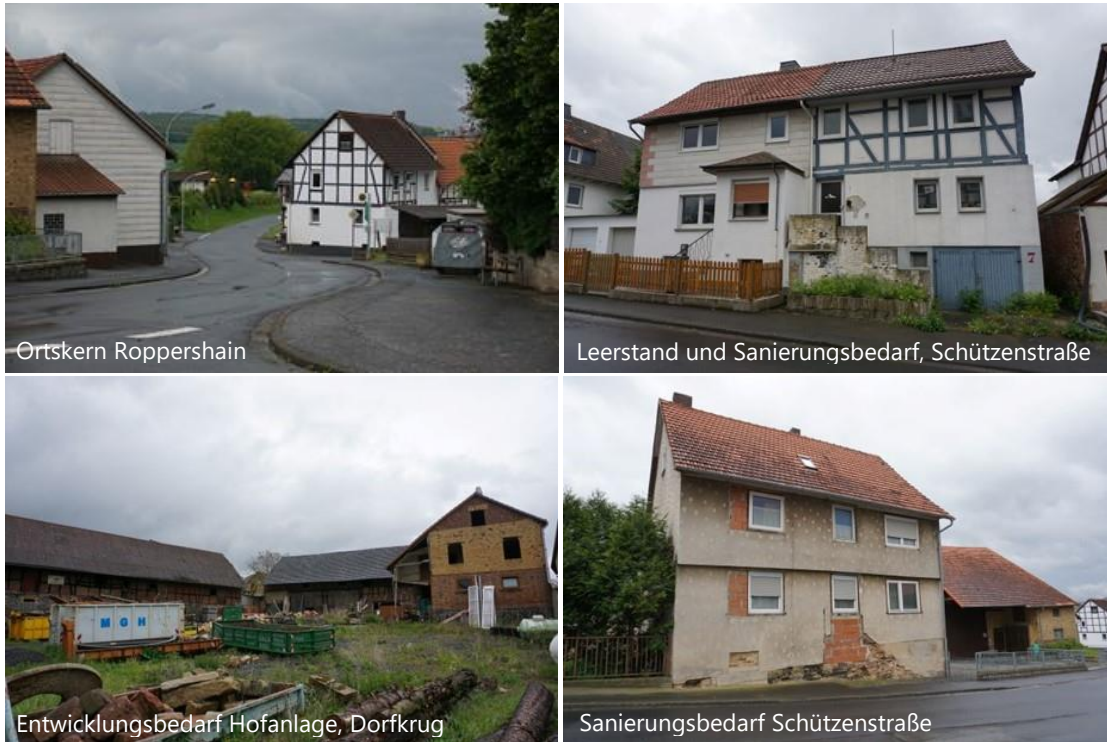
Abb. 108: Impressionen zu Baustruktur und -potenzialen in Roppershain
